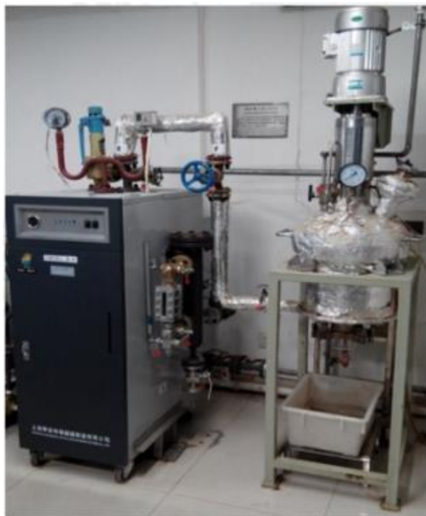
附图 1 干法预处理反应器设备实际图片
